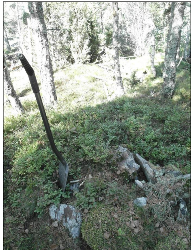
Kuivautusojasta louhittuja kiviä.
